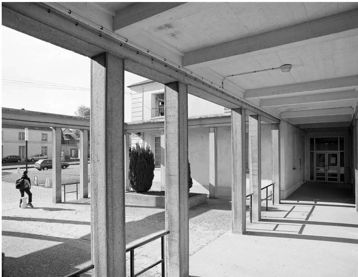
Vue de la galerie-portique conduisant aux bâtiments de l'école.
