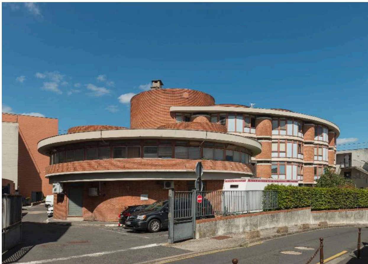
Vue générale de la façade postérieure.
