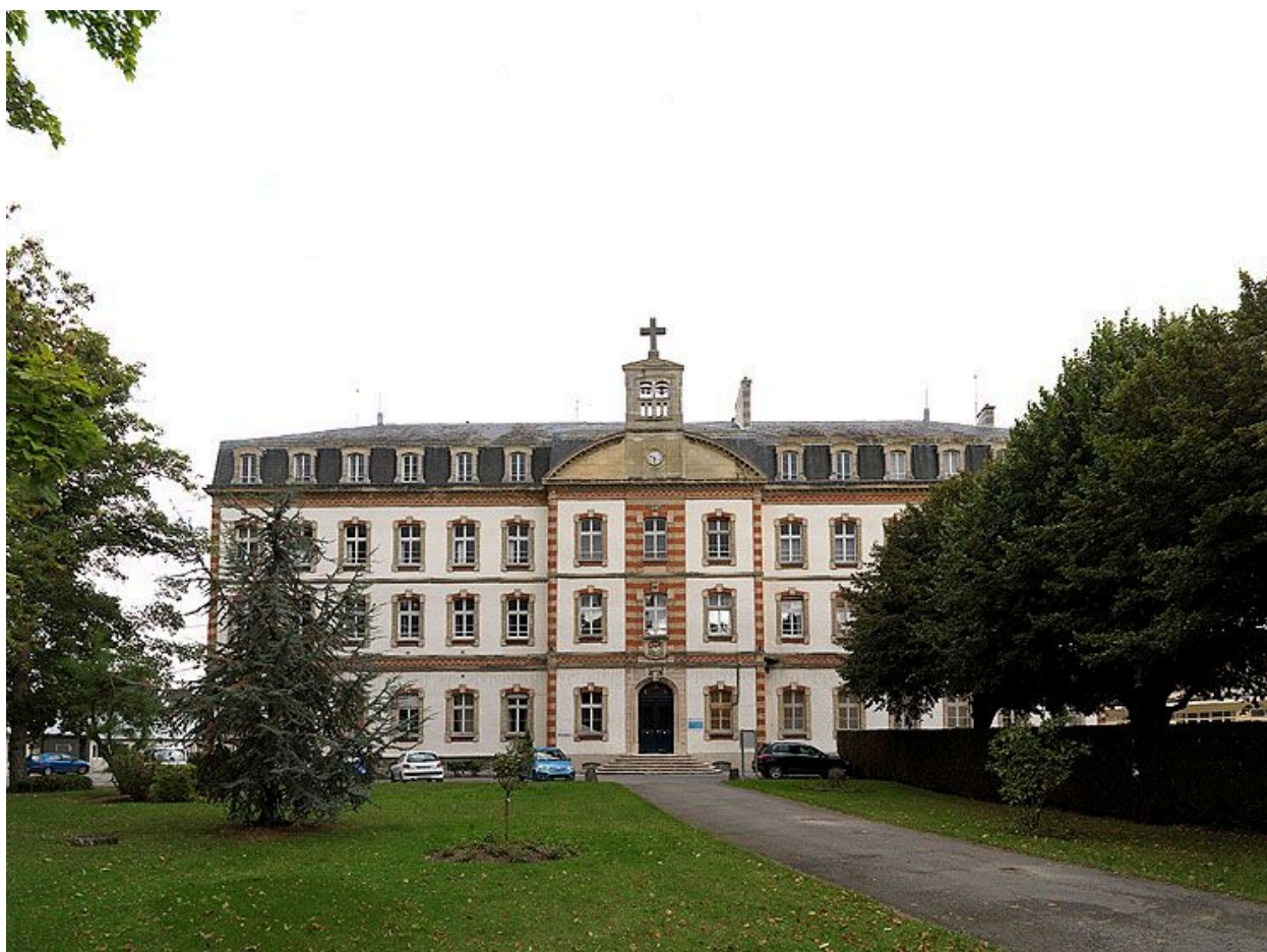
Elévation sud (sur jardin) du corps de bâtiment principal, achevé en 1887.
