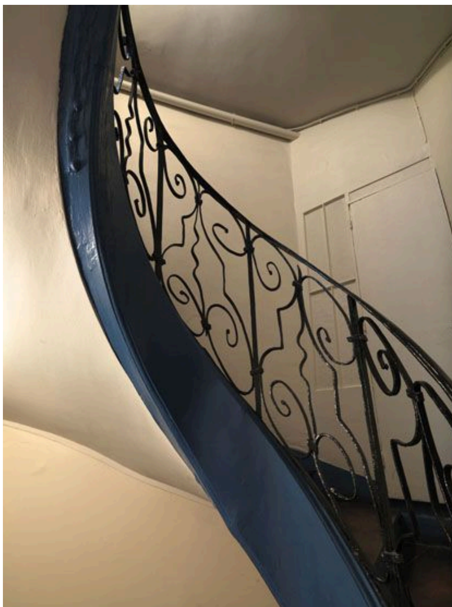
Détail des balustres.
