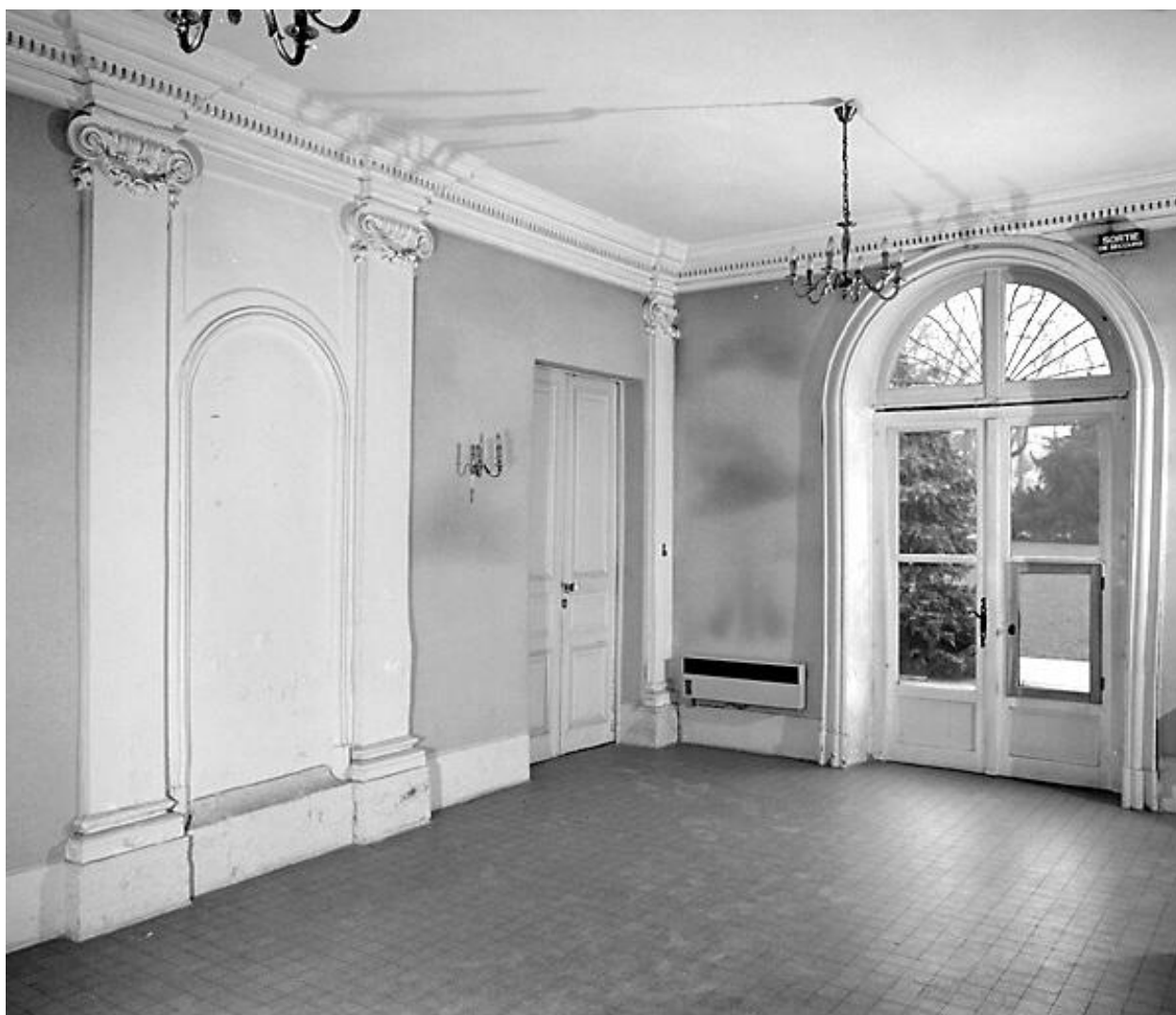
Vue d'ensemble du vestibule.
