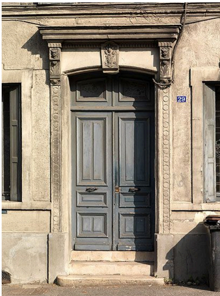
Maison 29 avenue Gallieni : détail du décor de la porte.
