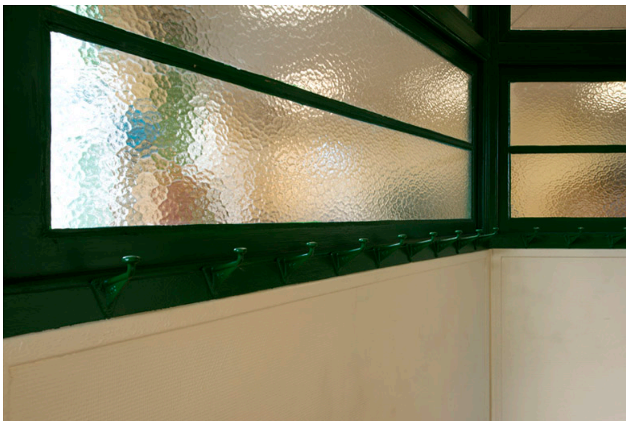
Vue de détail d'une fenêtre du couloir desservant les salles de classe.
