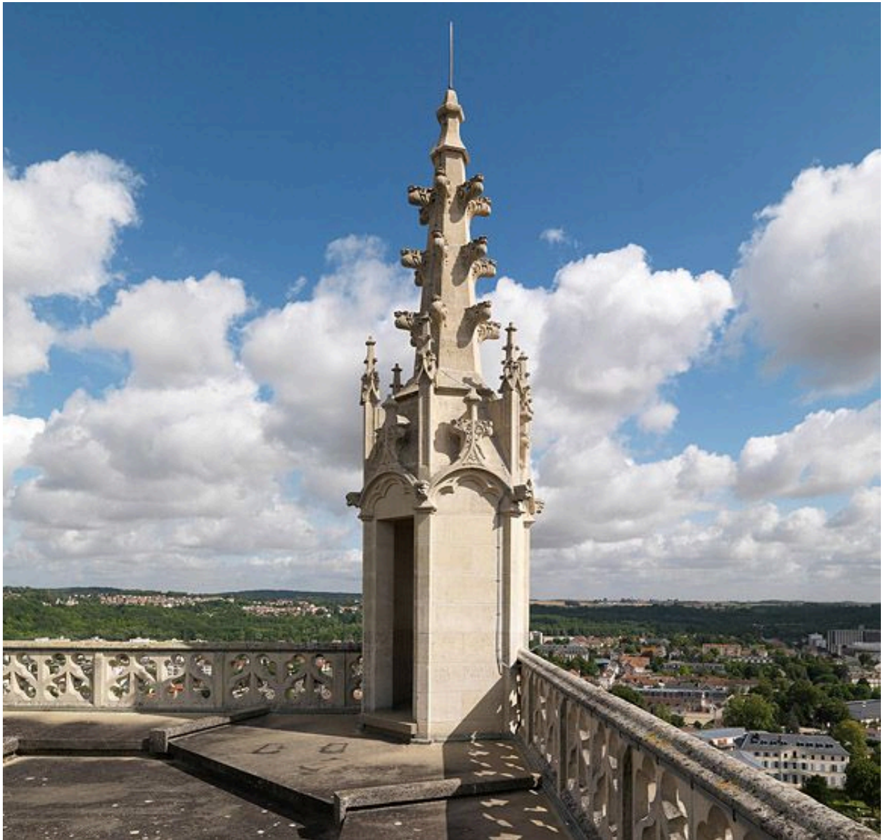
Pinacle au sommet de la tour nord.
