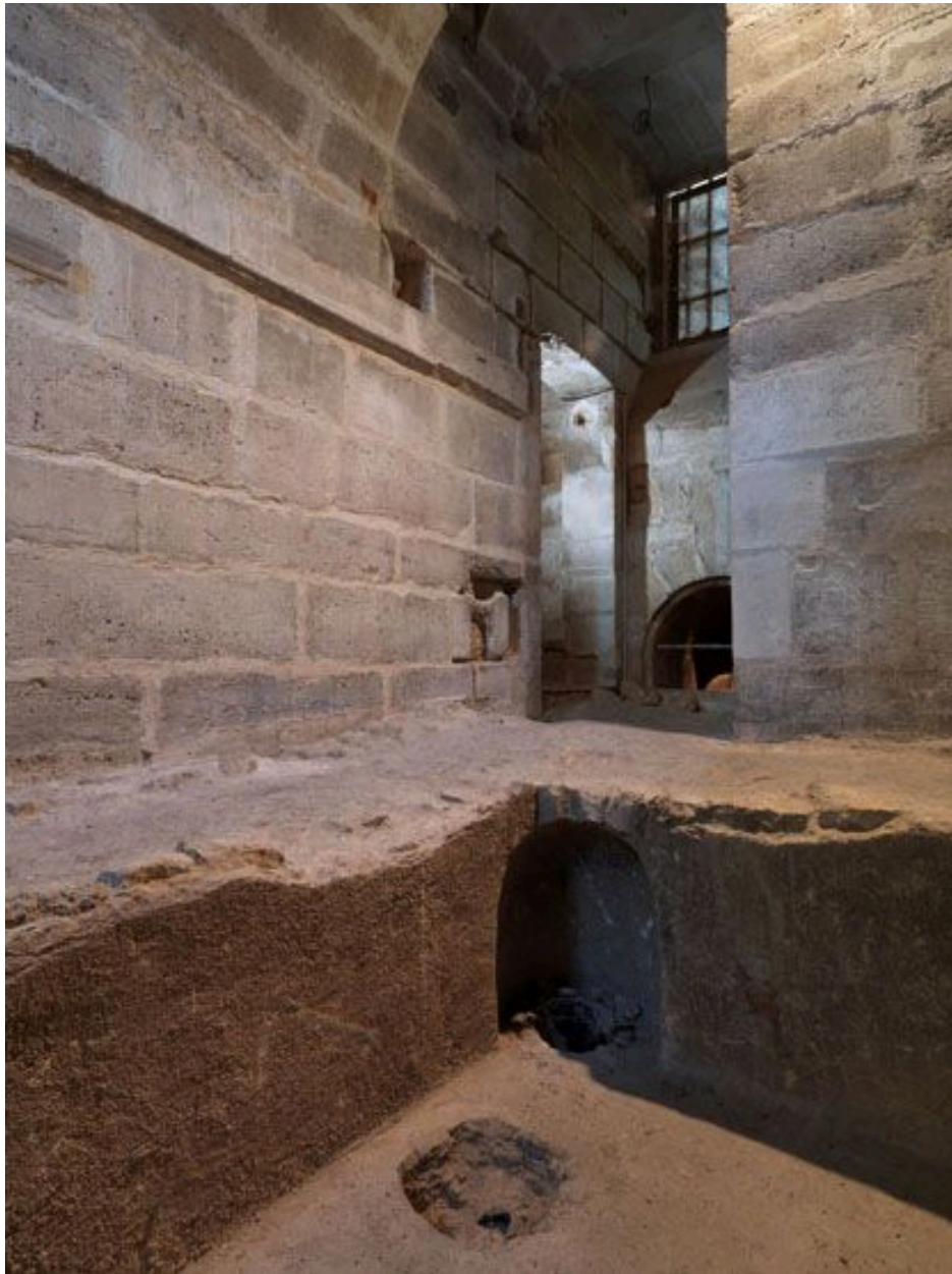
Paris 14e, Observatoire (avenue de l') 44. Maison du Fontainier : vue depuis le bassin de la Ville.
