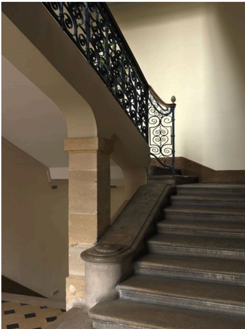
Vue du départ de l'escalier, qui a subi des modifications.
