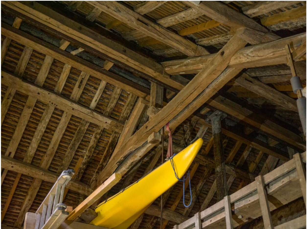
Vue de la charpente de la remise située rue du Lau.
