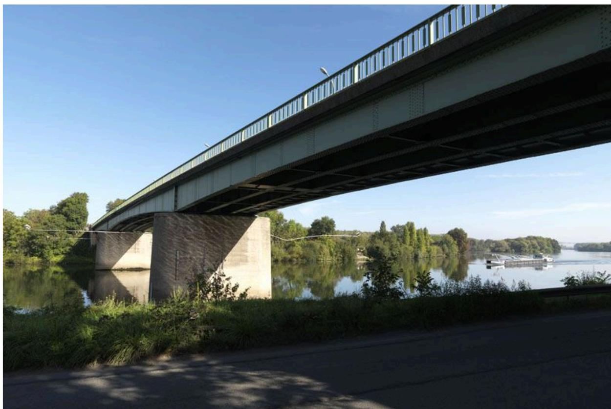
Tablier métallique et piles en béton vus depuis les quais.
