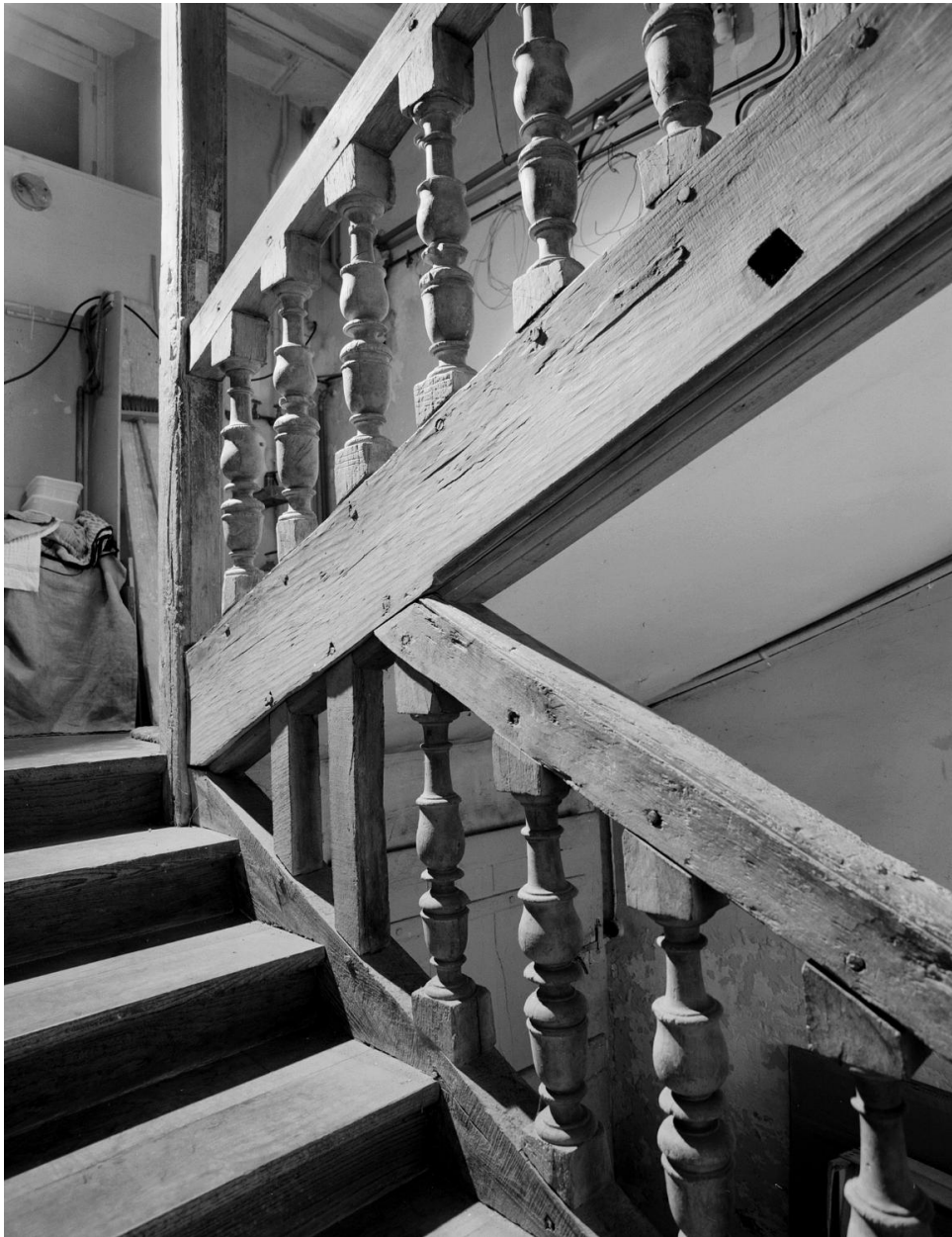
Escalier : détail de la rampe à balustes en bois.
