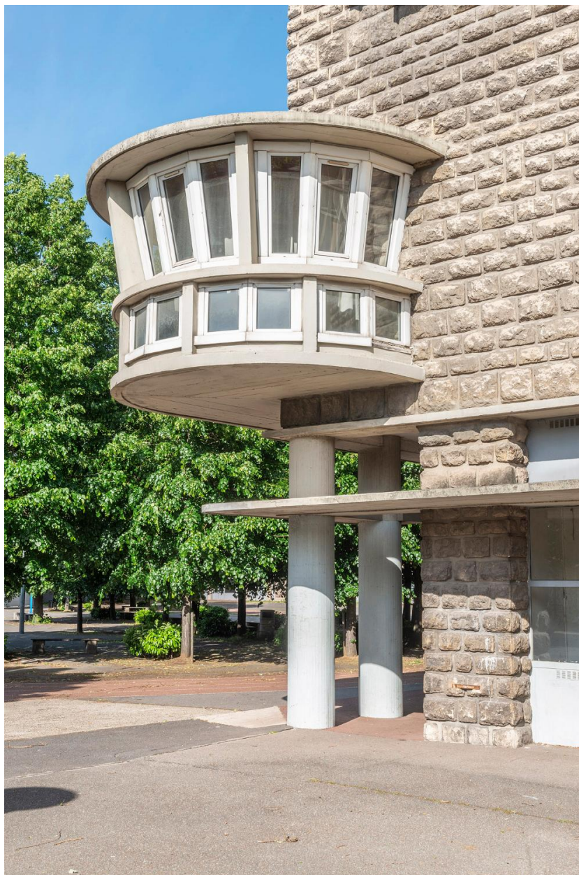
Détail du bureau de la directrice, placé dans une petite tour en demi-hors-œuvre.
