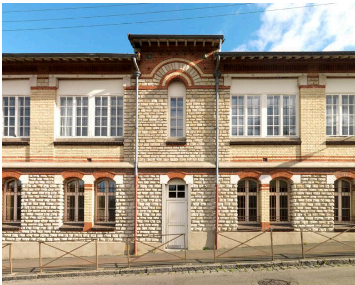
Partie centrale de la façade latérale, rue Castor.
