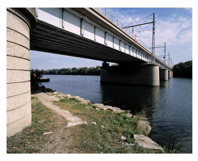
La première travée, du côté du pont établi lors du doublement des voies en 1903 (et reconstruit en 1952).
