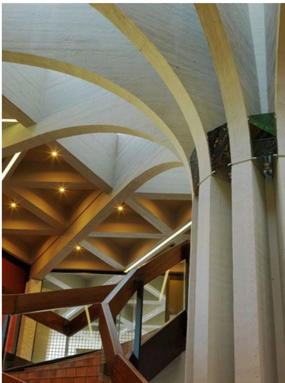
Détail des branches de béton évasées formant le haut du pilier du hall central et du plafond à caissons du premier étage.
