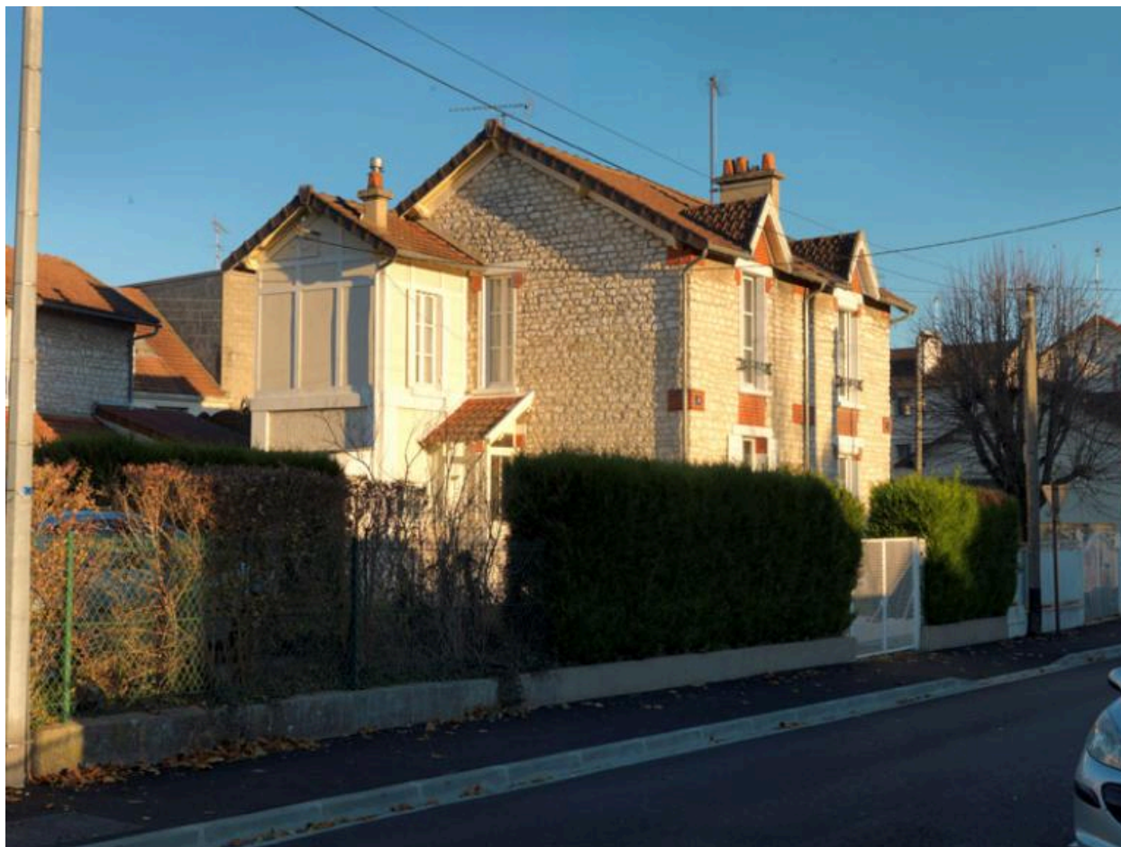
Vue d'une maison jumelle (type A), 69-71 rue Saint-Vincent.
