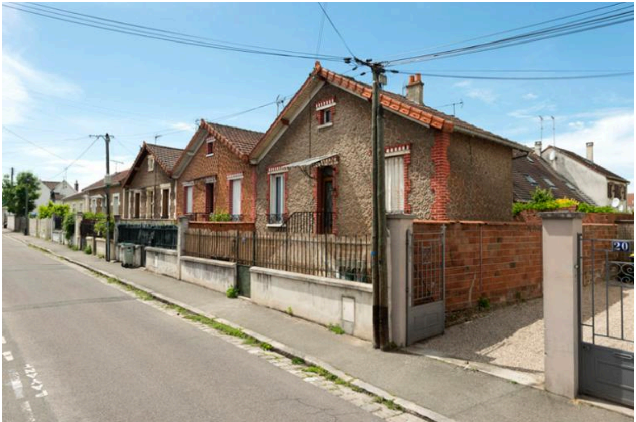
Ensemble de trois pavillons, 22-26 rue de Seine. Vue latérale.
