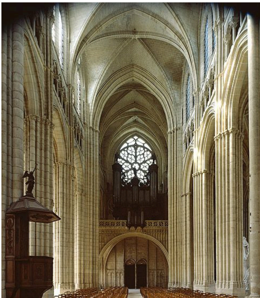
Le vaisseau central de la nef, vu de la croisée.
