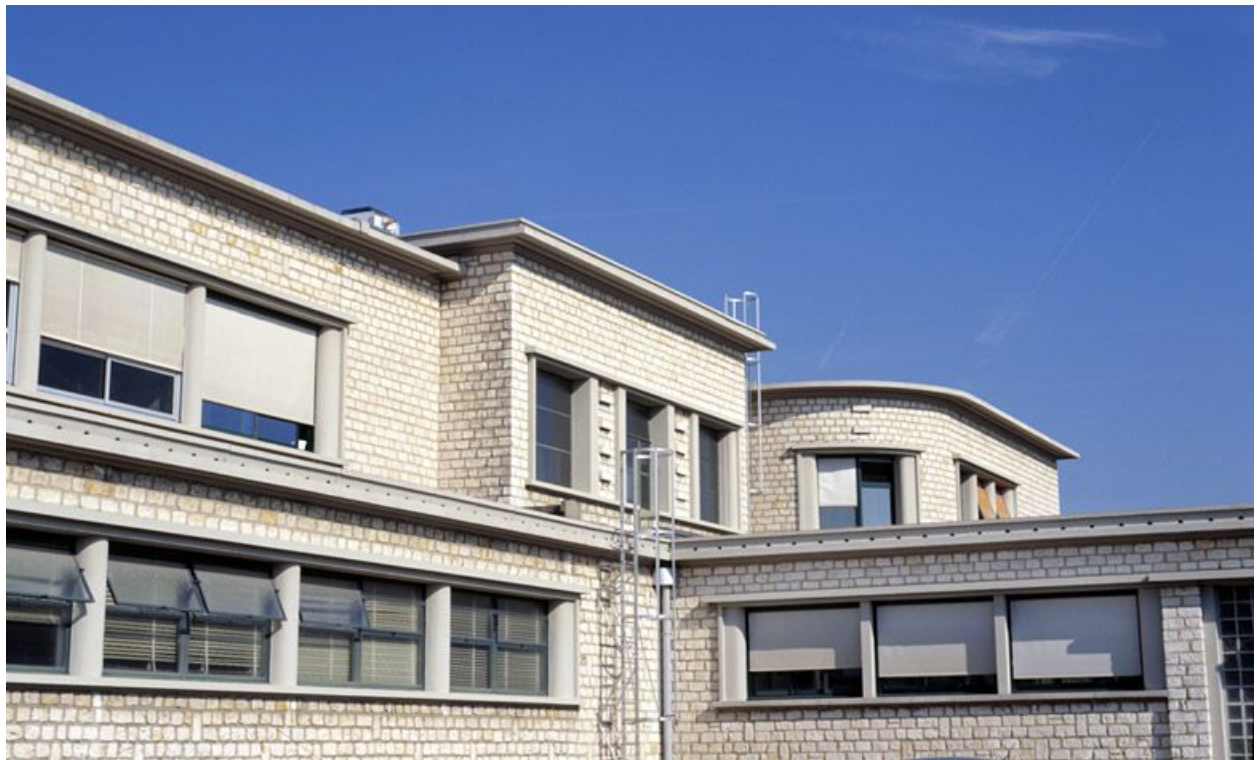
Détail de l'aile nord.
