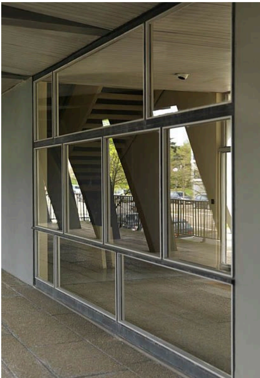
Vue des pilotis depuis un hall d'entrée.
