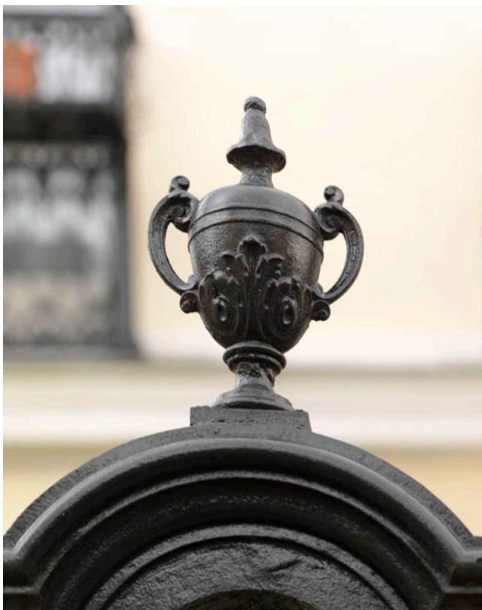
Fonte et ferronnerie ; détail du portail en fonte, 12 rue Gaston Israël. Vue de l'un des deux petits vases amortissant les piliers du portail.
