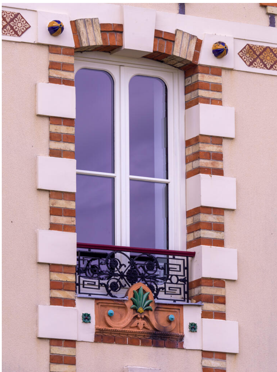
Vue de la façade nord, détail d'une fenêtre.
