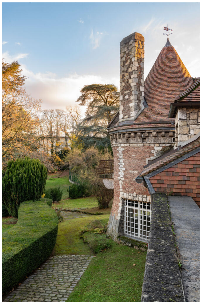
Villa des Tourneroches, tour sud-est
