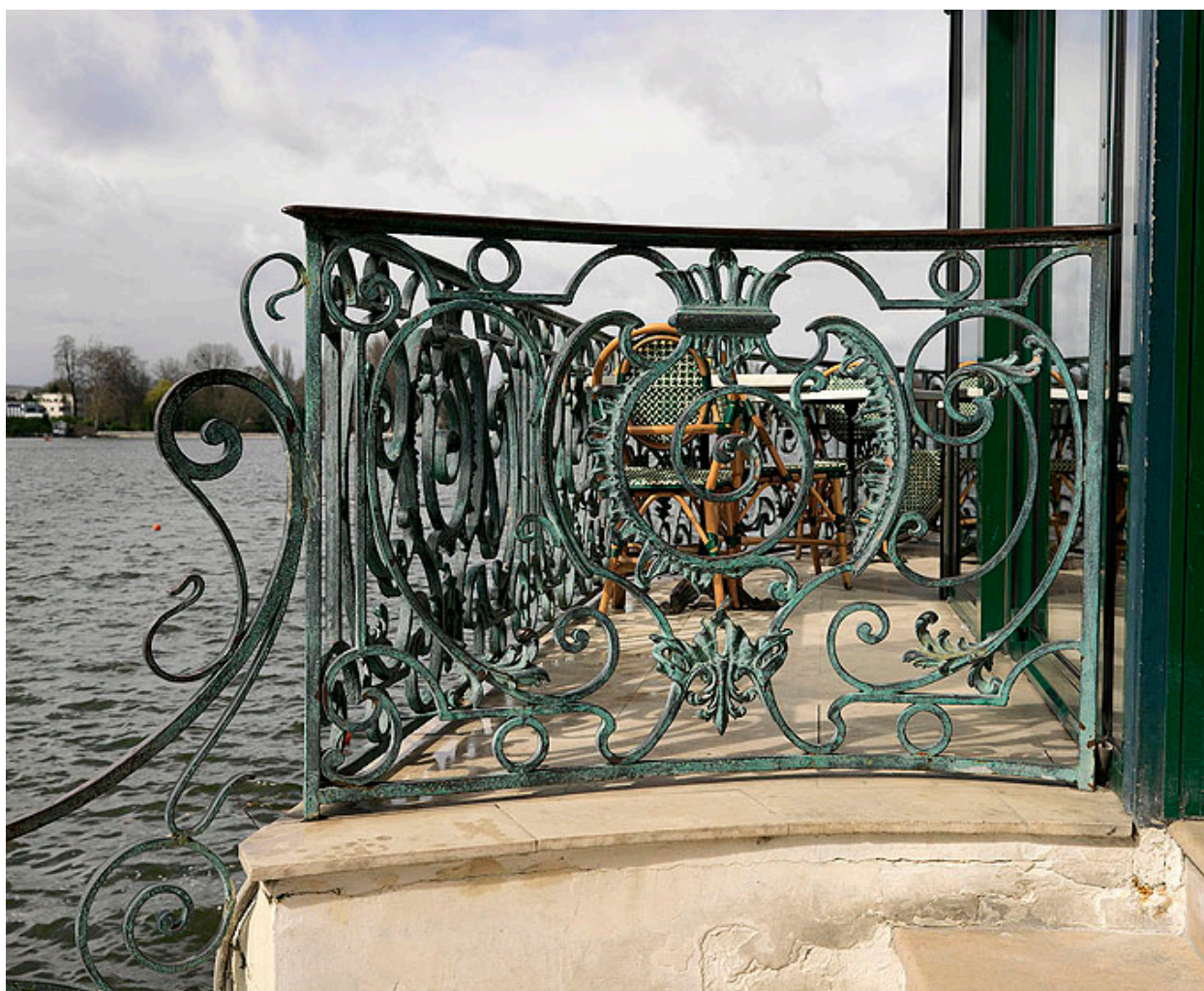
Détail du garde-corps en ferronnerie bordant la terrasse donnant sur le lac.
