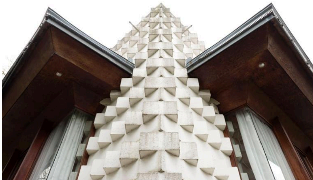
Vue du coffre de la cheminée prise de l'extérieur de la maison.
