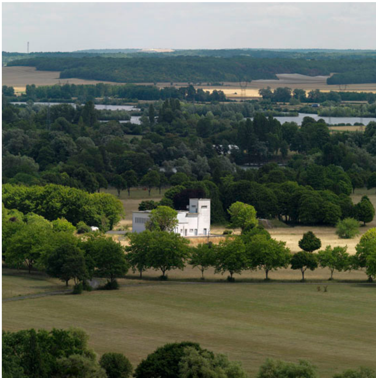
Silos de l'UNCAC Invivo de la Grande Paroisse. Paysages autour du site. Vus depuis la tour de travail du silo 6.
