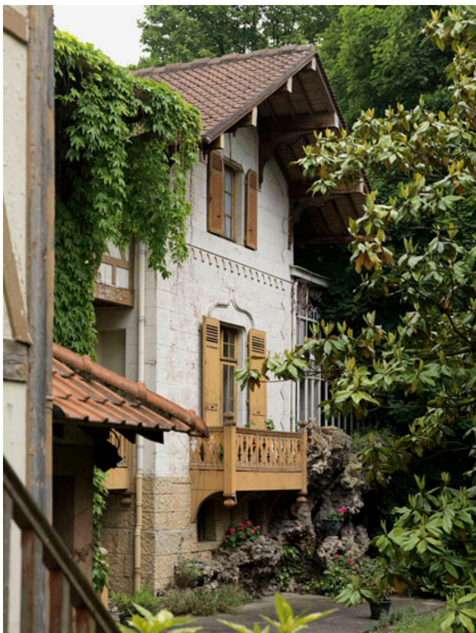
Façade d'entrée, détail du corps de bâtiment situé à droite.
