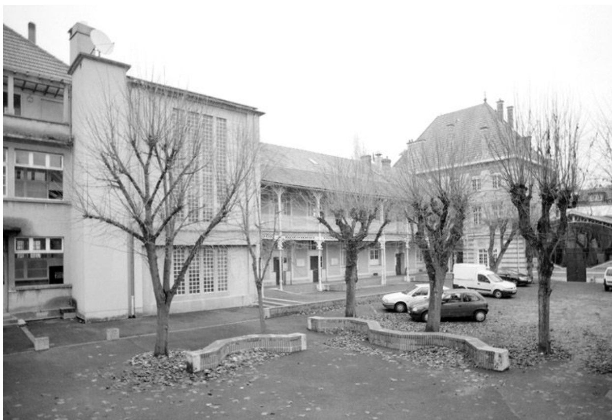
Vue générale de la façade sud (côté cour).
