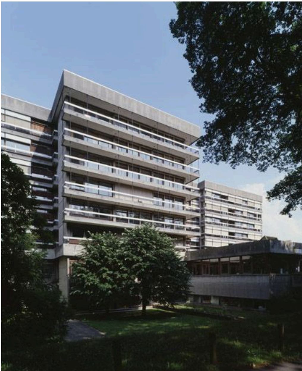
Vue de la façade principale du bâtiment Georges-Brassens.
