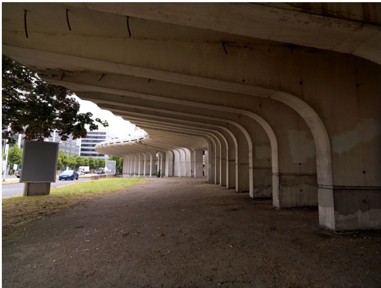
Parking régional du Mont d'Est, 1975-1977. Rampes d'accès.
