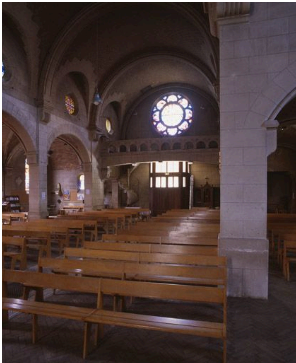
Vue de la nef en direction de la tribune et de l'entrée.
