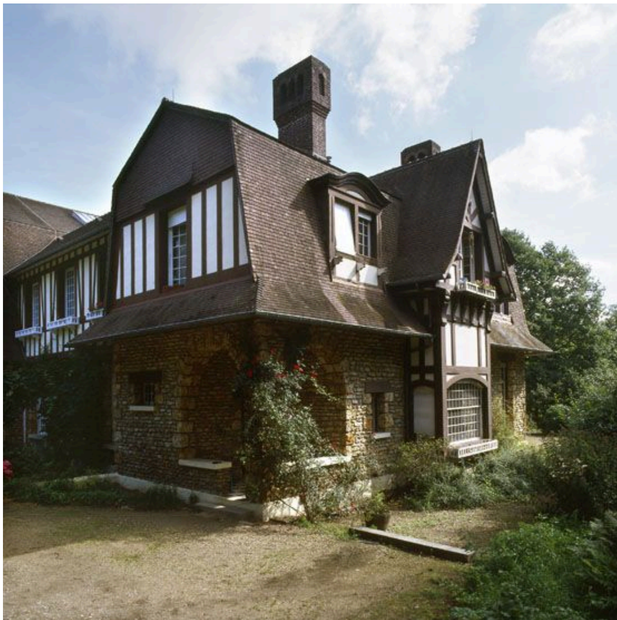
La façade latérale et son bow-window.
