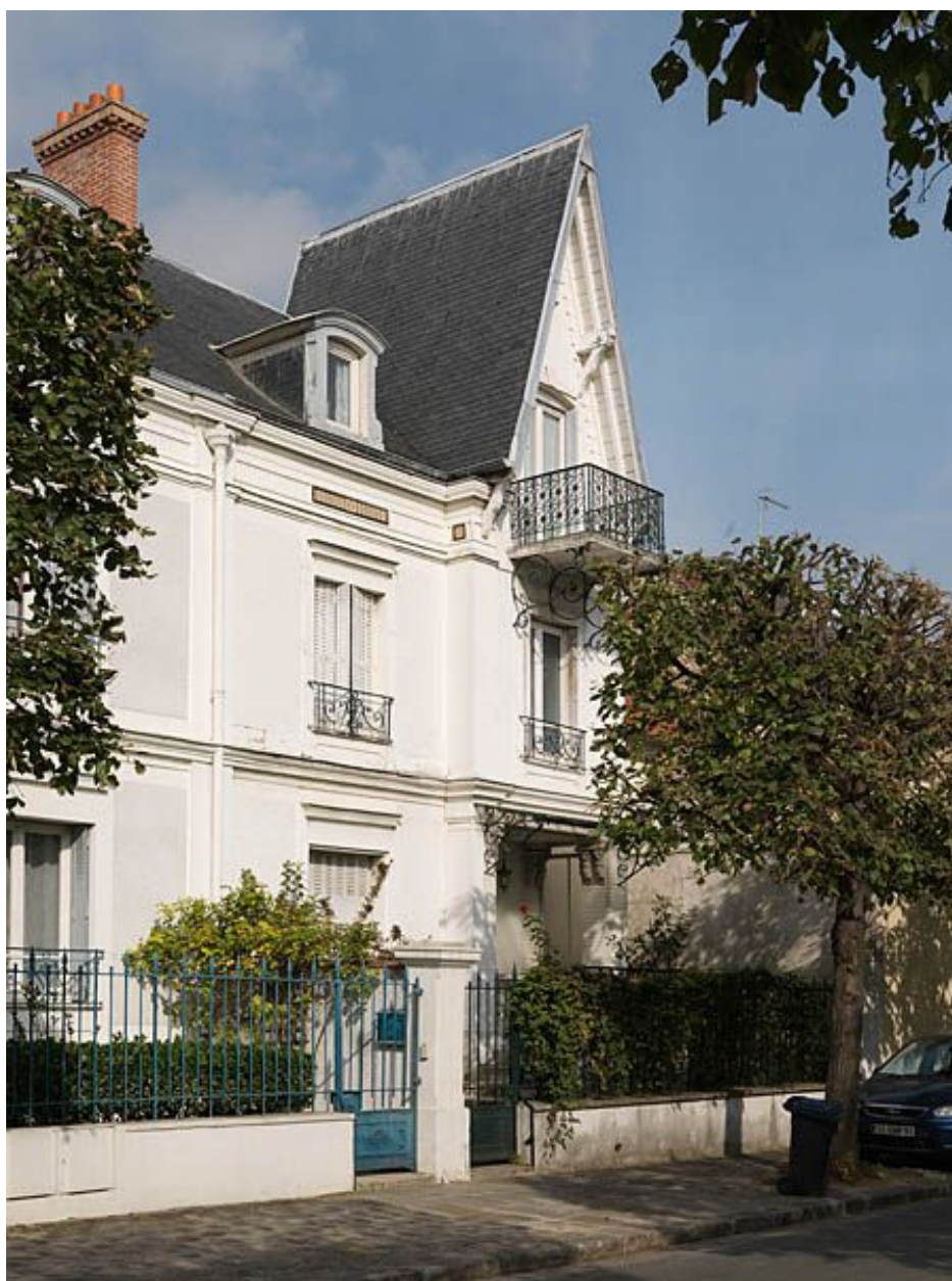
Thiais, maison jumelée, 14, 16 avenue Hoche. Elévation antérieure.
