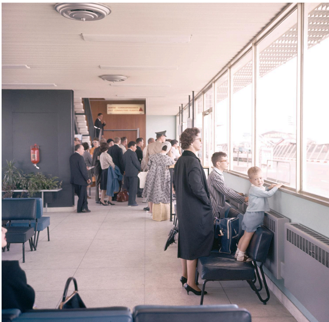
1961, salle d'embarquement, rez-de-chaussée coté piste.
