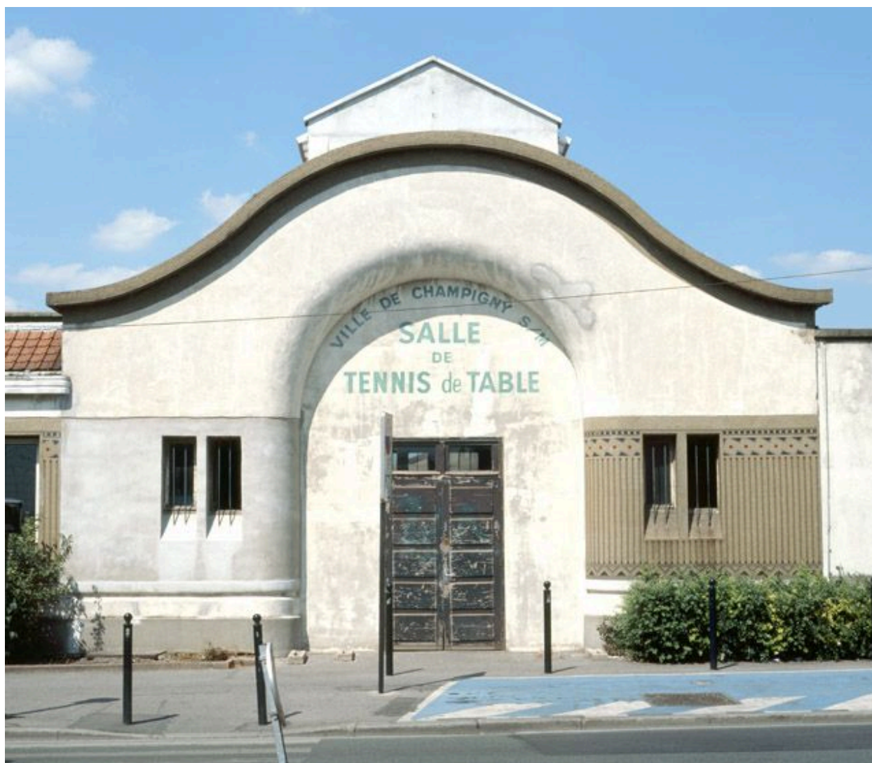
Vue rapprochée du lavoir désormais transformé en salle de sport.
