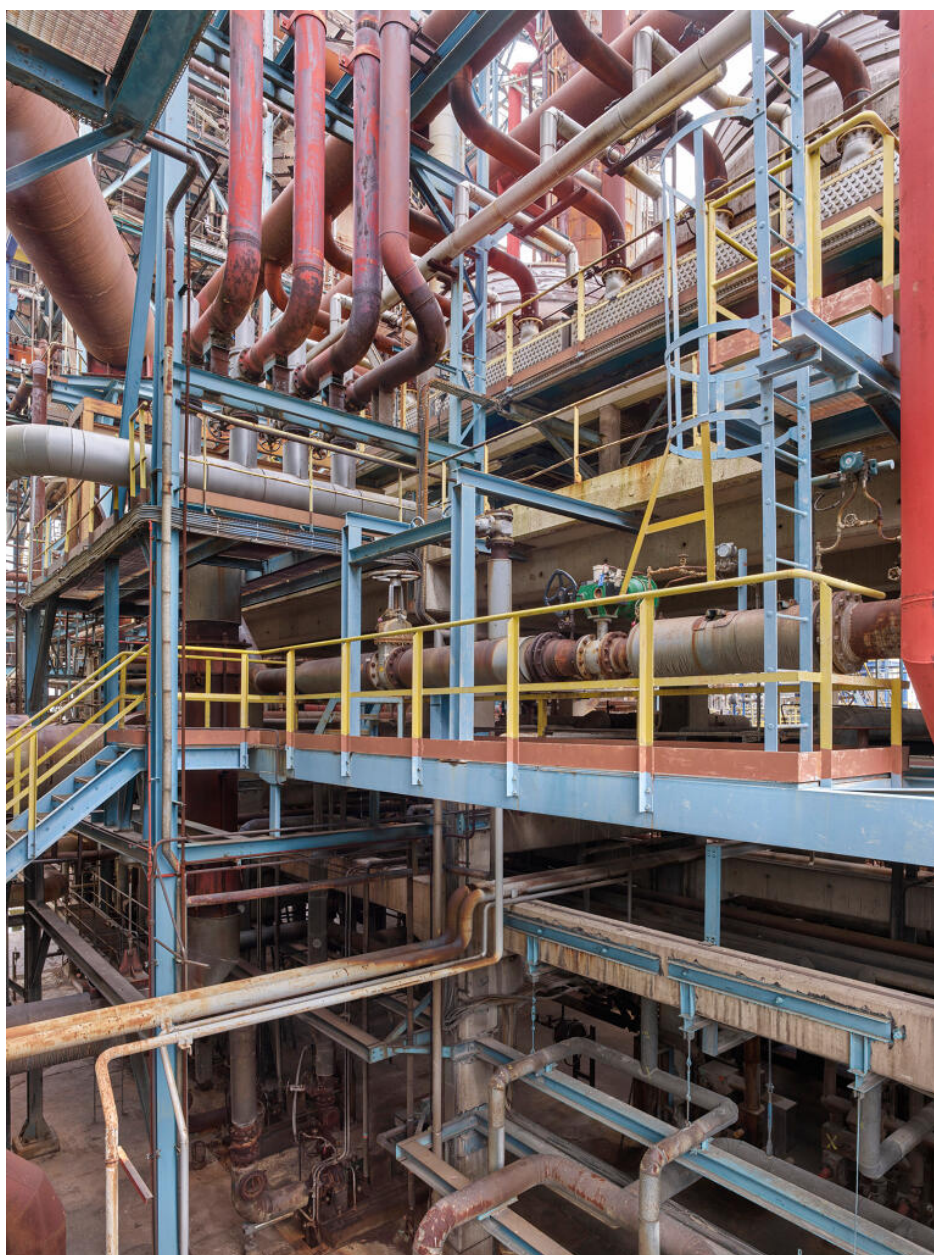
Unités Est - Zone FCC (Unité 651). Vue sur les lignes servant au transfert des produits.
