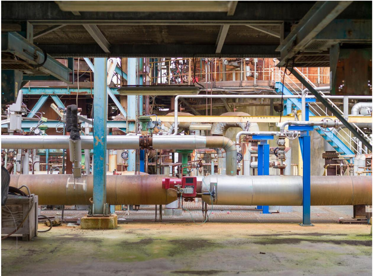
Unités Est - Zone FCC (Unité 651). Vanne automatique du circuit d'air de combustion du régénérateur du FCC (Unité 651).
