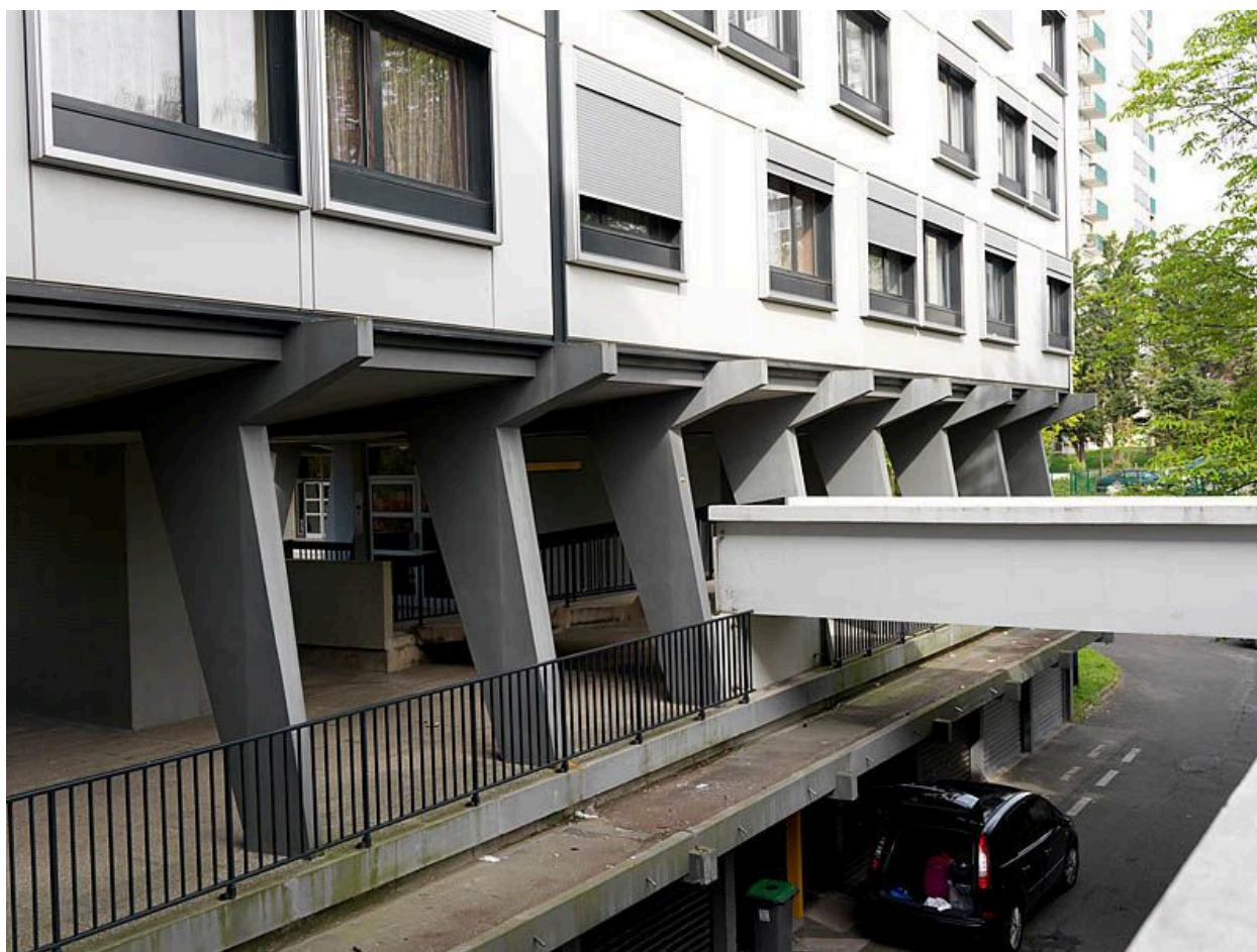
Parking, coursive et passerelle.
