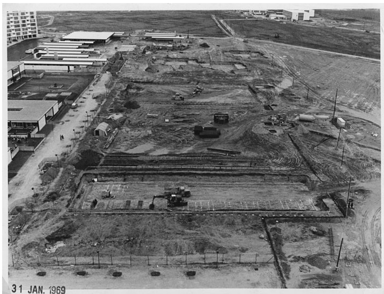
Chantier de la construction - 31 janvier 1969. (OPAC Meaux)
