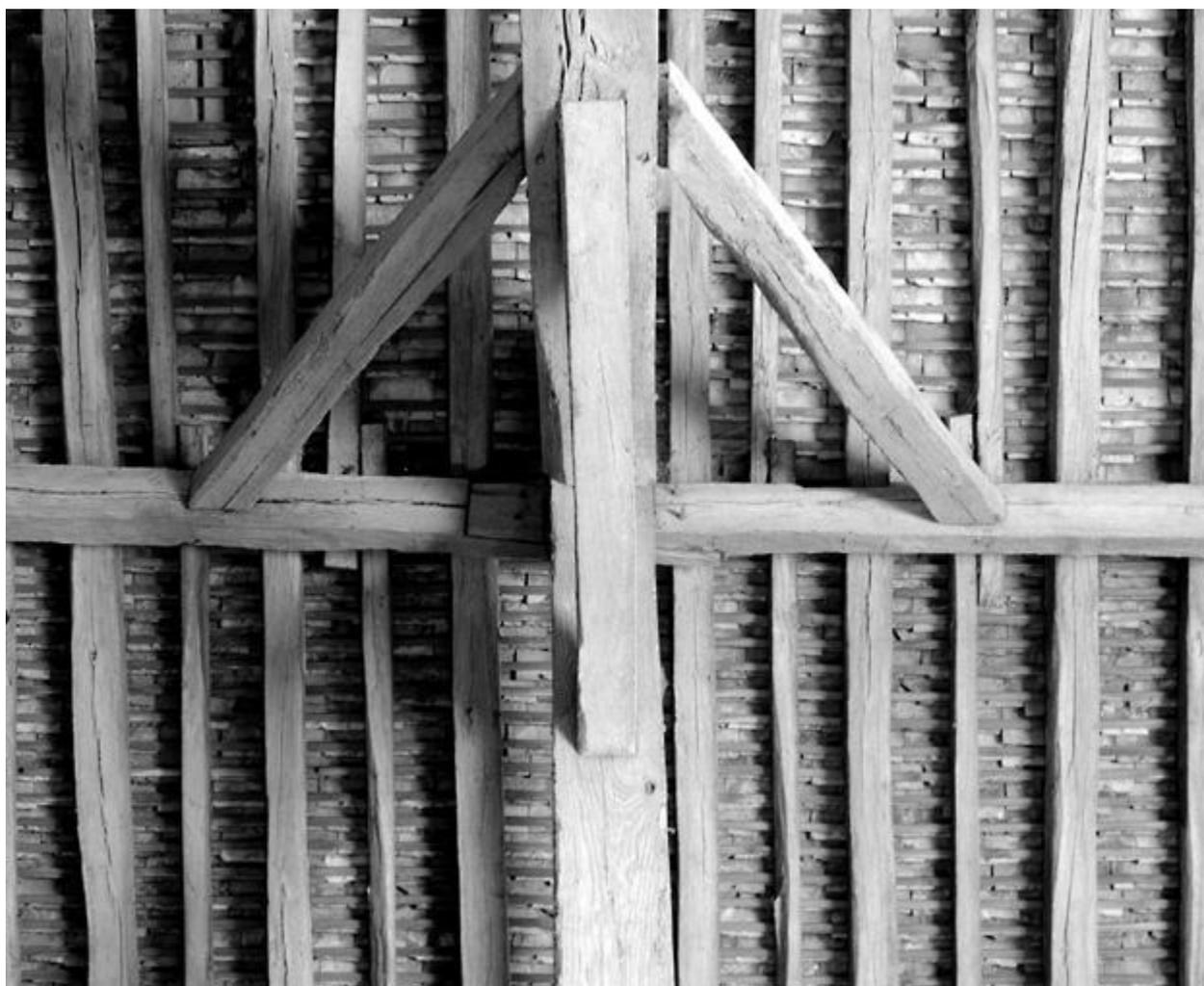
La grange, charpente : détail d'assemblage des pannes intermédiaires et contreventements. Assemblage des pannes en sifflet avec chevilles.
