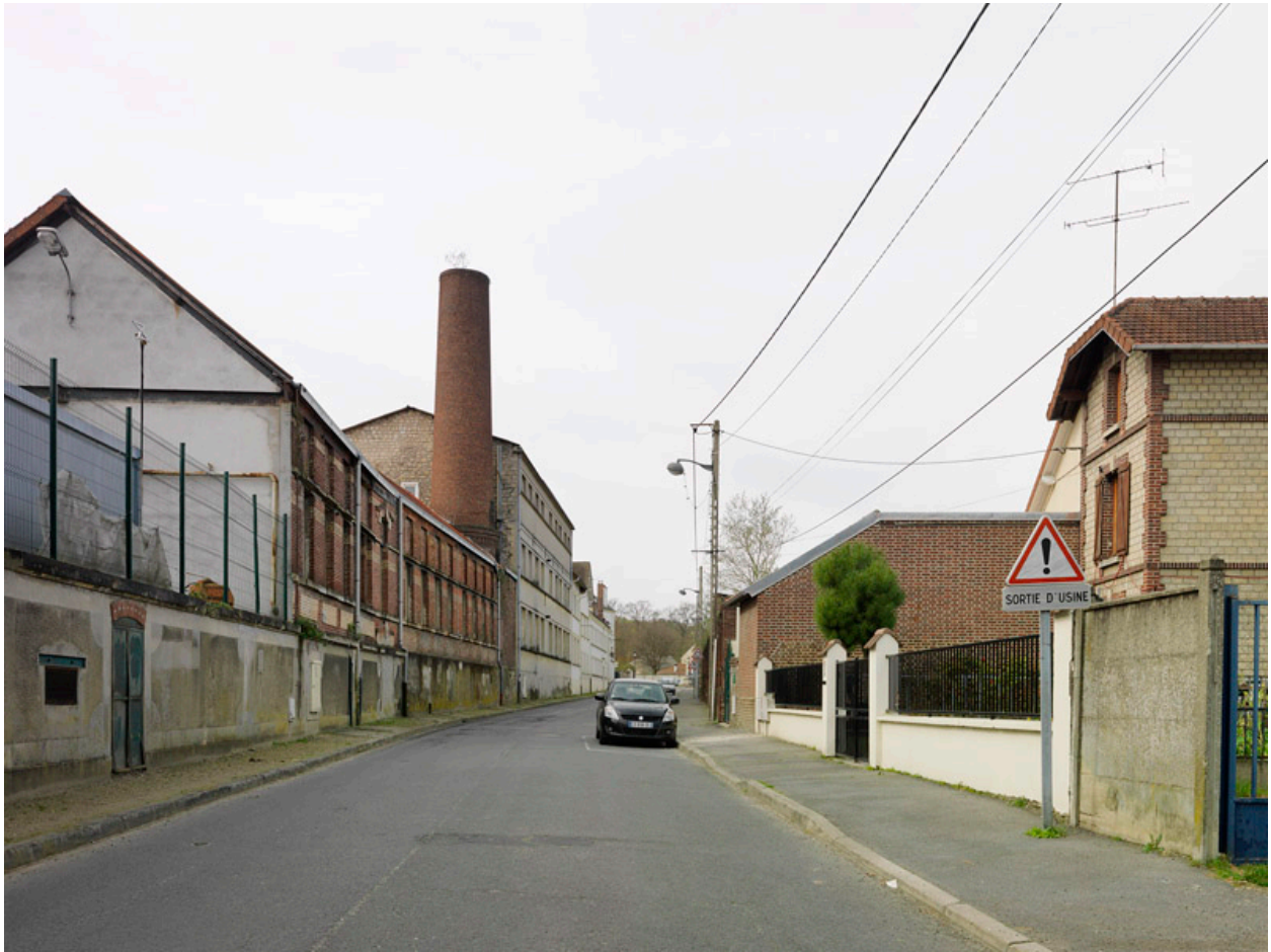
Asnières-sur-Oise. Rue longeant les ateliers de l'ancienne usine Delacoste puis Vulli.
