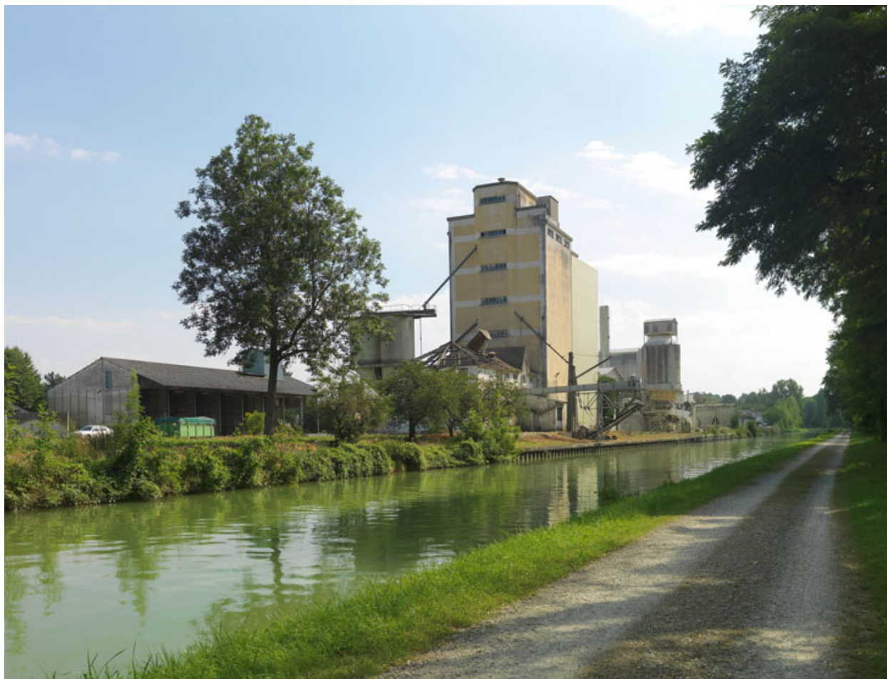
Silo vu du canal du Loing.
