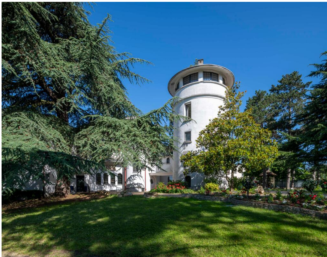
Vue générale de la façade sud dominée par la tour de l'ancien moulin.
