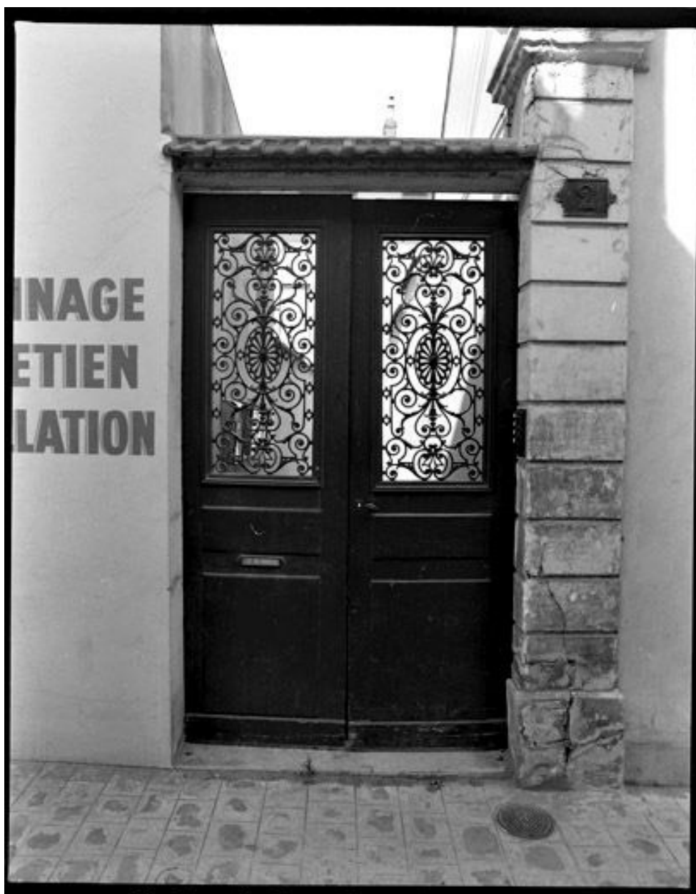
Maison, Metz (rue de) 2. La porte sur rue.
