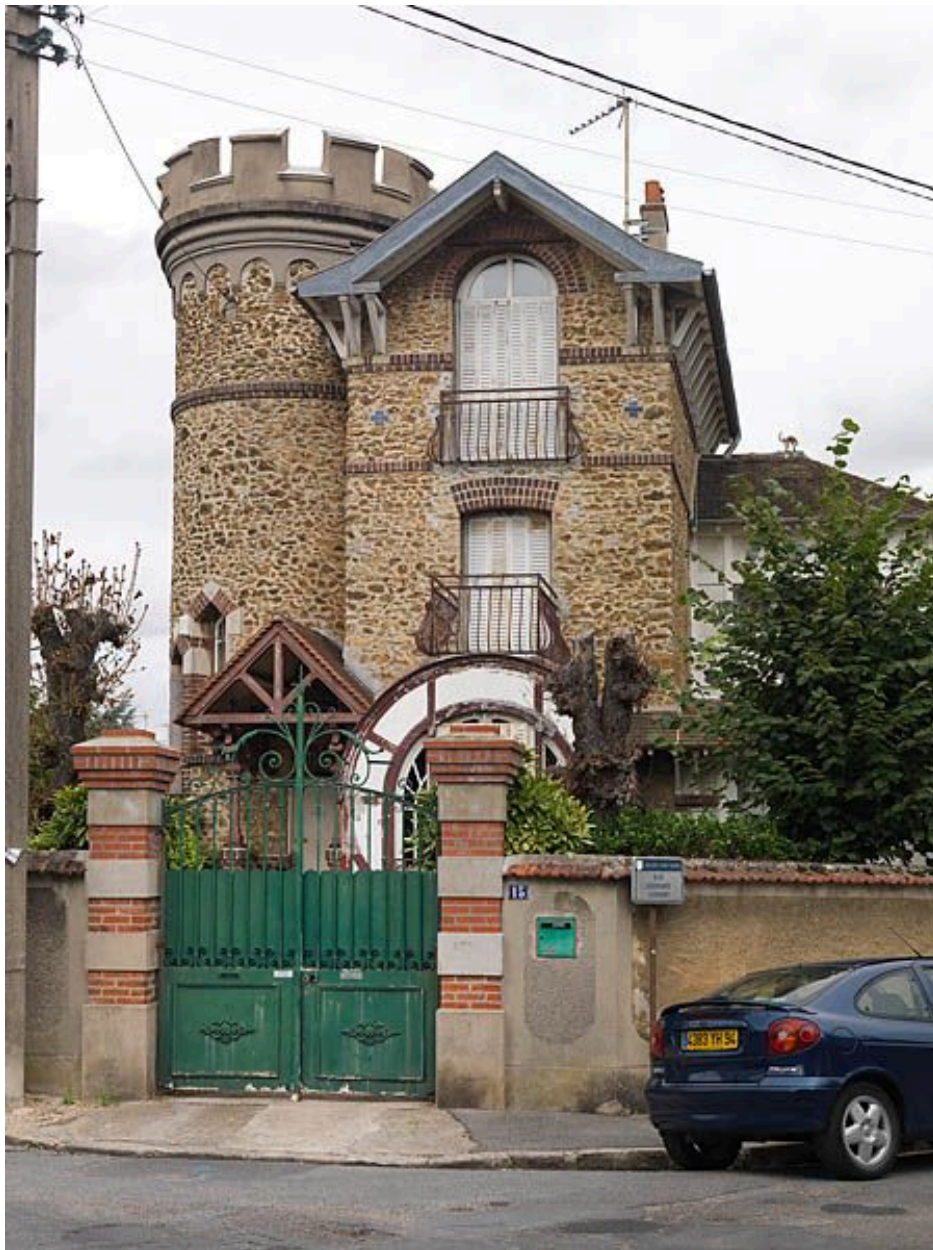
Ablon-sur-Seine, maison, 15 rue Edouard-Juvigny. Elévation antérieure. Les balcons en ferronnerie ont remplacé les balcons en bois.
