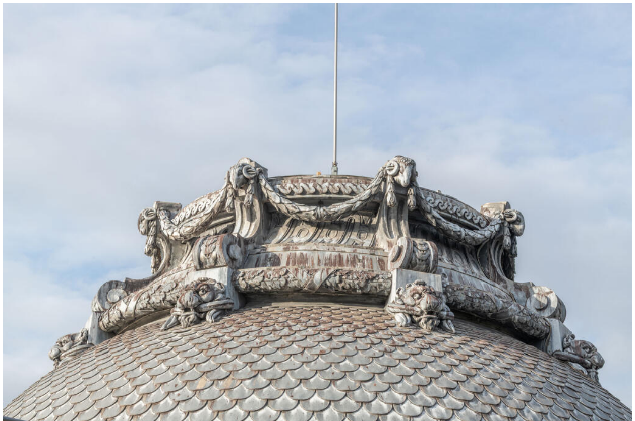
Détail du décor en plomb du dôme de l'avant-corps en rotonde.
