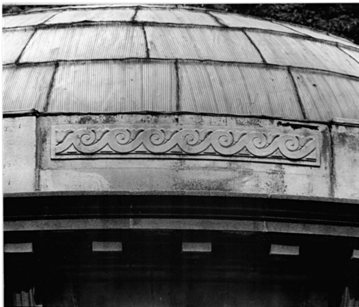
Décor de postes courant le long de la terrasse de la colonnade.
