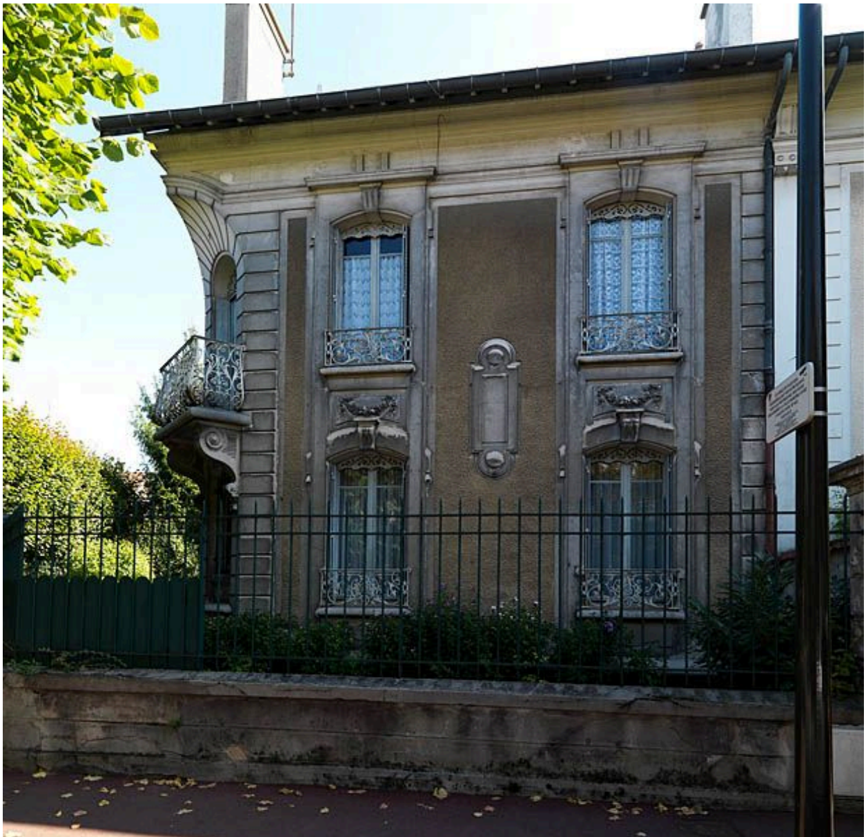
La façade de la maison d'angle, vue de la rue Gambetta.
